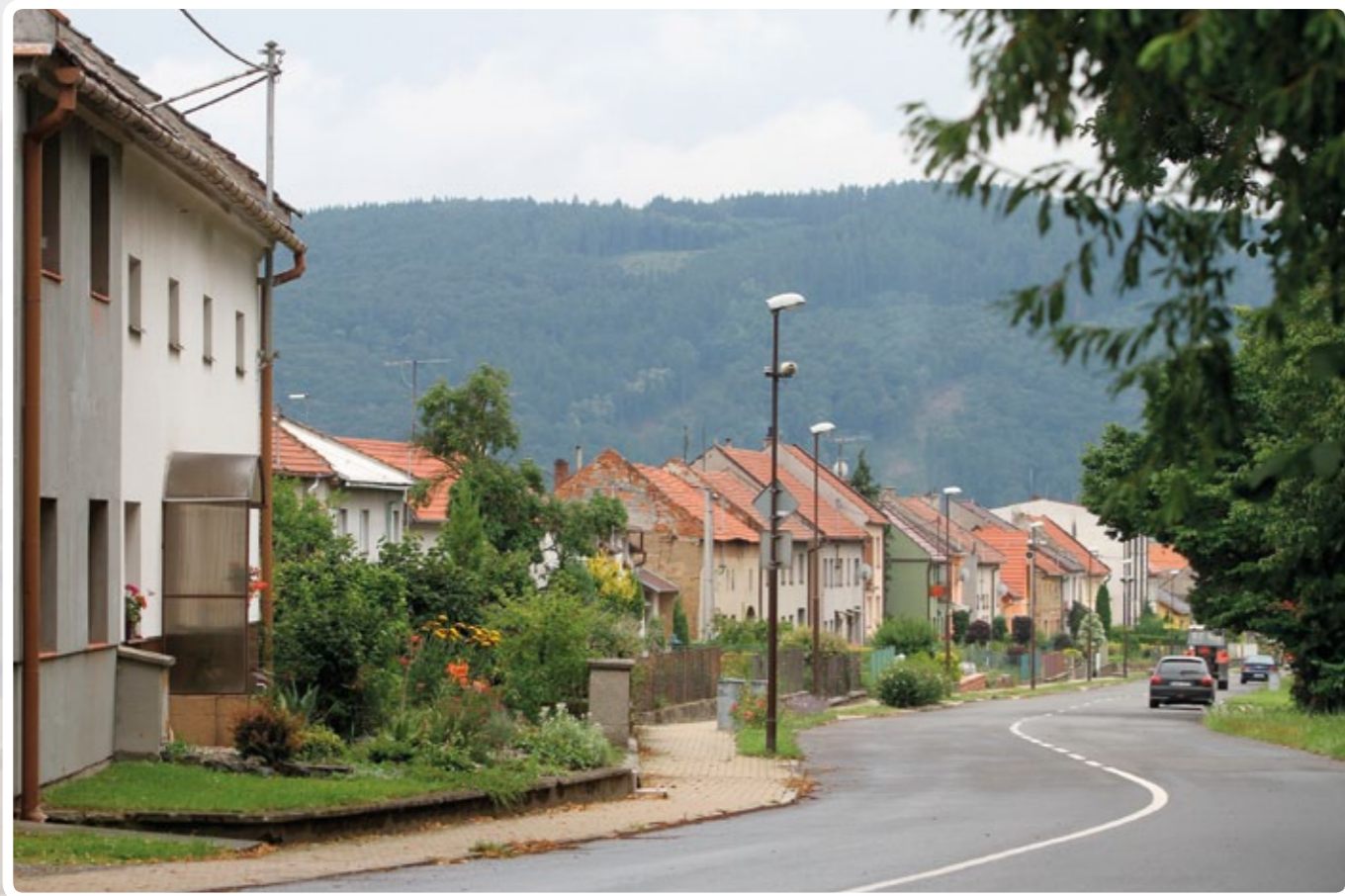
Pohled na Jezernici, 2011
