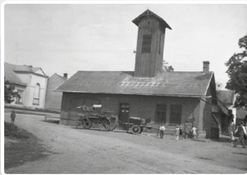
Původní hasičská zbrojnice, 1938
